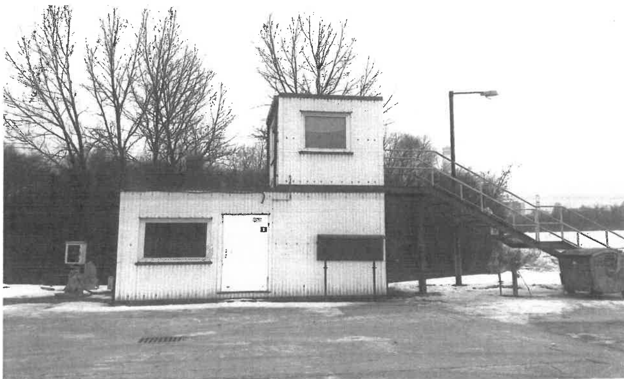
Zdjęcie punktu nr 5 Pomieszczenie ochrony.
