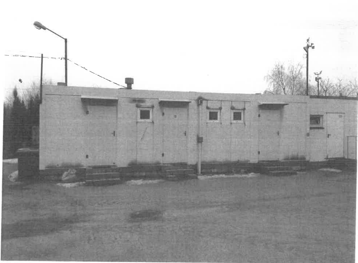
Zdjęcie punktu nr 2 Budynek socjalny i biuro.
